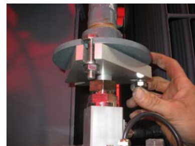
6. Appoggiare la flangia dell'essiccatore al tubo di connessione del conservatore e fissare le viti e rondelle.
