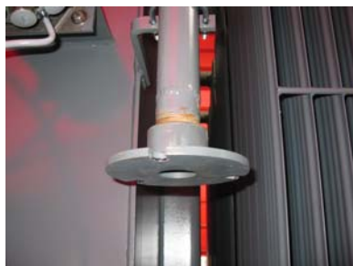
5. Tubo di collegamento proveniente dal conservatore del trasformatore con flangia già
